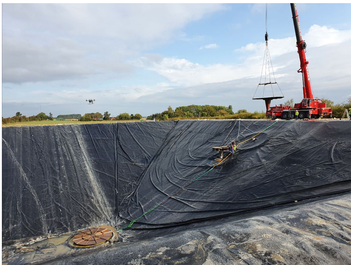
Figur 12.15: Groplagret vid installation av polypropylenliner.
